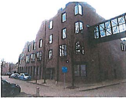
NMTs kontorsbyggnad i Nieuwegein
